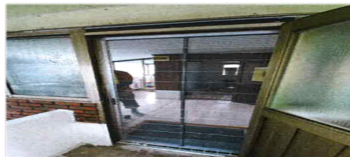
《현관 방충망 설치》
